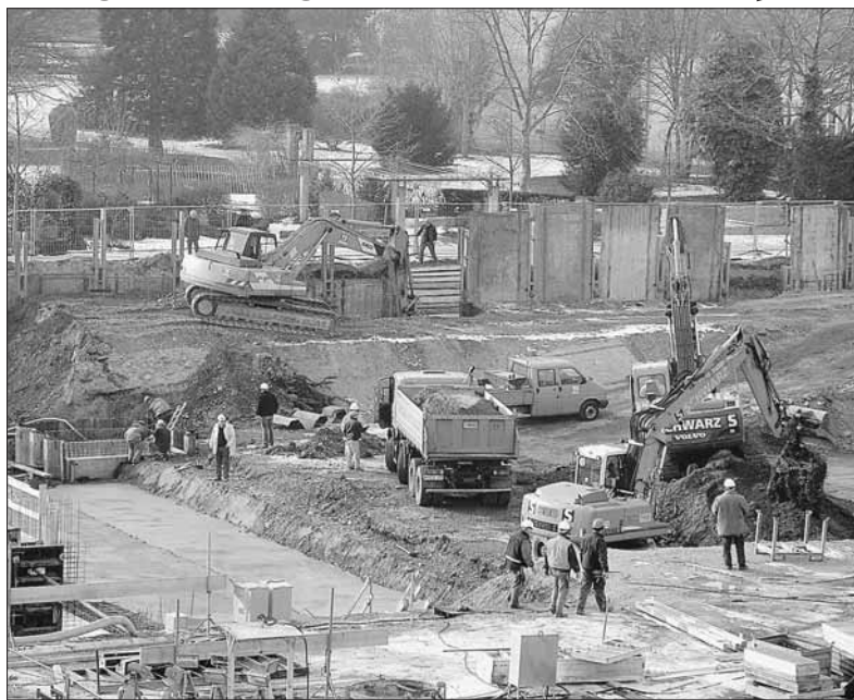
Der Fortschritt auf dem Baugelände der künftigen Stadthalle macht weitere sichtbare Fortschritte. Inzwischen nehmen das Foyer des Untergeschosses und der Orchestergraben Gestalt an. Ab März wird eine zweite Etappe des Bauvorhabens eingeläutet: der Bau der Tiefgarage beginnt. In diesem Zusammenhang steht dann ab diesem Zeitpunkt der Parkplatz hinter dem Rathaus nicht mehr als Parkfläche zur Verfügung, da an dieser Stelle die Tiefgarage entstehen wird.
