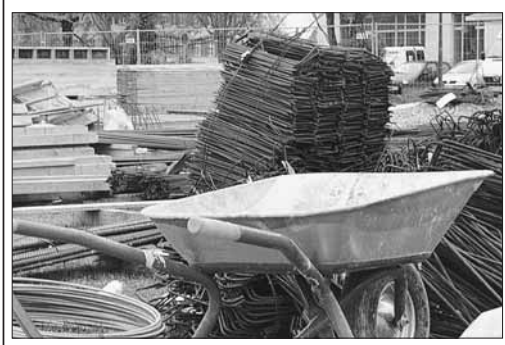
...von der Stadthallen-Baustelle.
