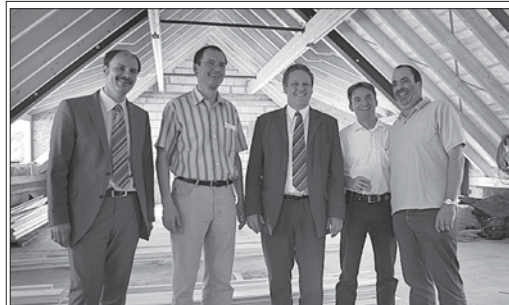
Am vergangenen Donnerstag konnte die Poppele-Zunft Richtfest beim Zunftschür-Anbau feiern. In Anwesenheit von Oberbürgermeister Oliver Ehret und Bürgermeister in spe Bernd Häusler freute sich Zunftmeister Stephan Glunk über die reibungslos verlaufenden Arbeiten, die von Architekt Wolfgang Hein bestens koordiniert werden. Das Foto zeigt (von links): Bernd Häusler, Stephan Glunk, Oliver Ehret, Architekt Wolfgang Hein und Ulrich Götz.
