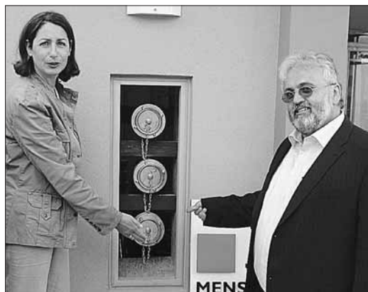
Schulleiterin Ulrike Armbruster und Klaus Müller, Projektleiter der städtischen Abteilung „Gebäudemanagement“, zeigen auf die zwei Füllleitungen und eine Entlüftungsleitung der neuen Pelletheizung in der Schillerschule.
