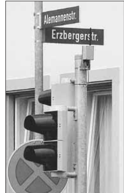
An der Kreuzung Alemannenstraße/Erzbergerstraße sorgt die neue Ampelanlage für eine sichere Verkehrssteuerung.
