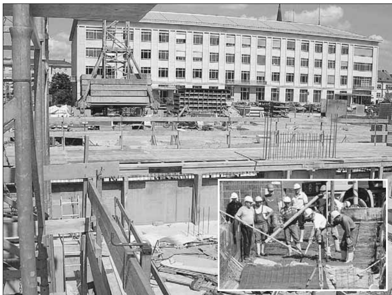
Blick von der künftigen Vorbühne aufs Rathaus: Zügig voran geht es mit dem Singener Stadthallen-Neubau. Beim Vor-Ort-Termin von SINGEN KOMMUNAL wurde gerade der Arbeitsraum der Tiefgaragenzufahrt vollführt. Zudem gibt es jetzt einen dritten Kran. Vor der „Gems“ stellt man aktuell gerade die Wände des 1.OG her. Dort befinden sich später die Künstlergarderoben und einige Haustechnikräume. Die Arbeiten an den Wänden des 1.OG des Verwaltungsbau sind derzeit gleichfalls im Gange. Der Aufzugsschacht ist bereits bis auf die Höhe der Oberkante des 2.OG betoniert. Rechts neben dem Aufzugsschacht steht einseitig die Schalung für die Stützen, zwischen denen einmal die Faltwände den Saal vom Foyer trennen. Vergangene Woche wurden Gleise verlegt, um einen der Krane aus dem Baufeld der zukünftigen Tiefgarage zu fahren.
