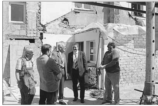
Richtfest für das neue Bürgerhaus in Überlingen a. R.: Oberbürgermeister Oliver Ehret sprach allen Beteiligten seine Anerkennung und den Dank für die bereits geleistete Arbeit aus.
