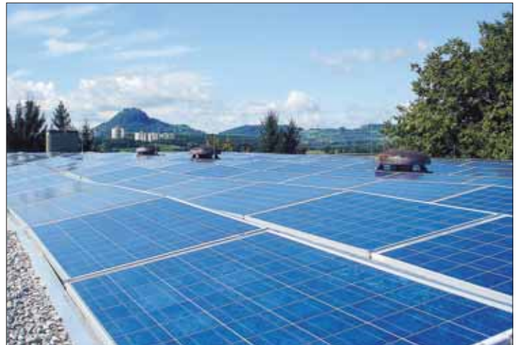
Auf dem Dach der Schlossberghalle in Friedlingen wandelt eine Photovoltaik-Anlage auf 530 Quadratmetern Sonnenenergie in Strom um.
