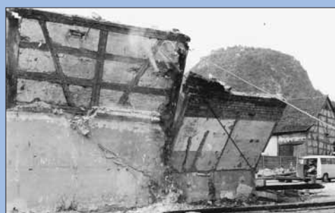
1957 mussten für den Rathaus-Neubau im Alten Singener Dorf zwölf historische Häuser abgerissen werden.
