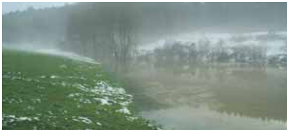
»Hochwasser« wurde beim Damm oberhalb von Steißlingen in den letzten Tagen für Testzwecke produziert. sub-Bild: le
