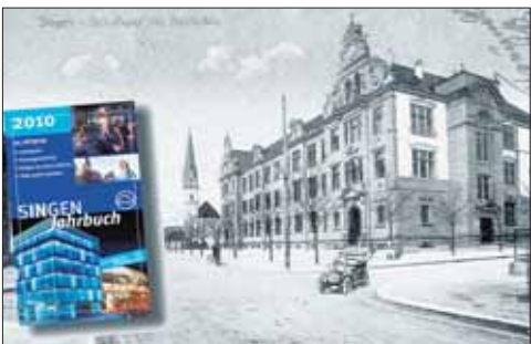
Die Ekkehardschule – das erste städtische Gebäude in Singen – nach ihrer Fertigstellung (1901)
