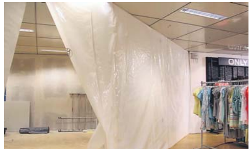
Im Kaufhaus Karstadt wird bei laufendem Betrieb umgebaut.
