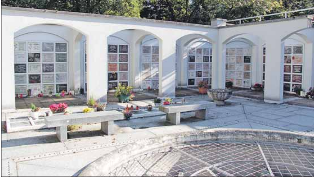
Die Urnenanlage (versunkene Stadt, Abteilung A neue Abteilung 009) auf dem Waldfriedhof wird in den kommenden Wochen saniert. Beim Gräberbesuch kann es daher zu Einschränkungen und Behinderungen kommen. Es wird um Verständnis gebeten.
