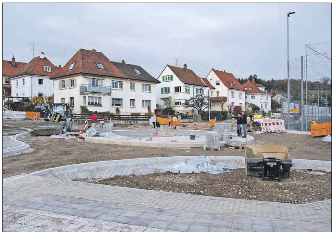
Nicht mehr lange eine Baustelle: Bald heißt es „Freie Fahrt“ im Kreisverkehr Friedinger Straße/Zum Posthalterswaldle.
