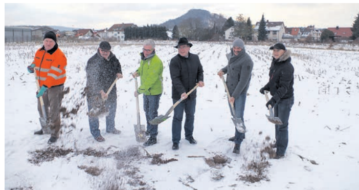
Trotz Schnee und gefrorenem Boden wurde der Spatenstich für das neue Gewerbegebiet in Rielasingen vollzogen. swb-Bild: of
