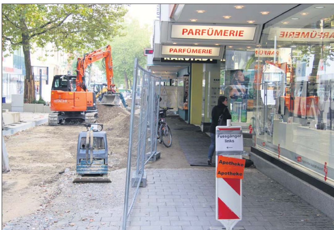
Die Bauarbeiten in der Hegastraße kommen gut voran. So wie es aussieht, werden die Arbeiten bis voraussichtlich Ende November abgeschlossen sein. Zurzeit können die Fußgänger einen Durchgang entlang des H&M-Gebäudes nehmen. Auf der anderen Seite der Baustelle gibt es ebenfalls einen Durchgang zu den dortigen Geschäften, die allesamt für ihre Kundschaft geöffnet haben.
