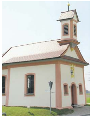
Erstrahlt dank »Hohenfels hat Zukunft« in neuem Glanz: Die Eligius-Kapelle wurde innen und außen saniert.
