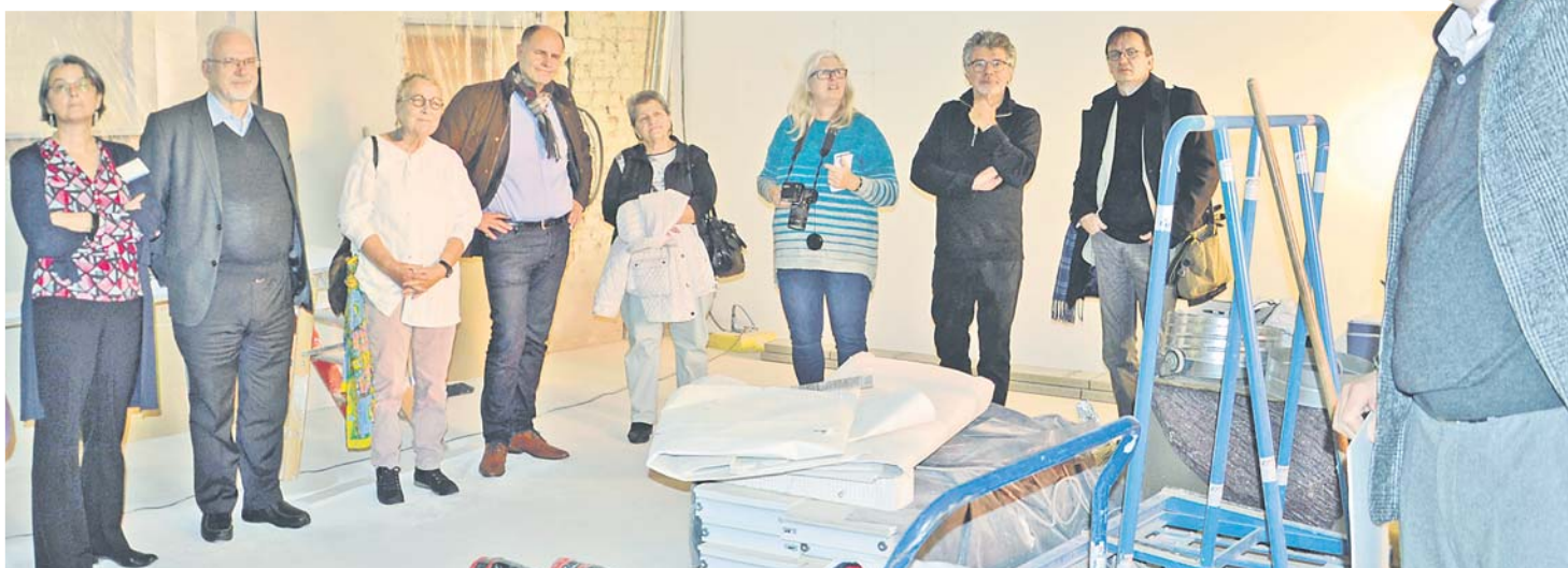
Die Mitglieder des Verwaltungs- und Finanzausschusses besuchten mit OB Häusler zusammen die Baustelle der Krankenhauskapelle im Singener Klinikum. Architekt Jörg Wuhrer (rechts) sowie die Klinikseelsorger stellten das Projekt vor.
