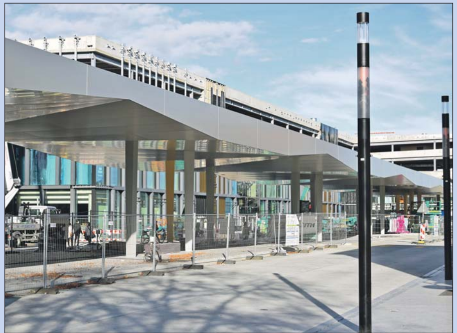
Sobald die Bauarbeiten an der Außenfassade des Cano abgeschlossen sind, kann der neue Bahnhofplatz geöffnet werden.
